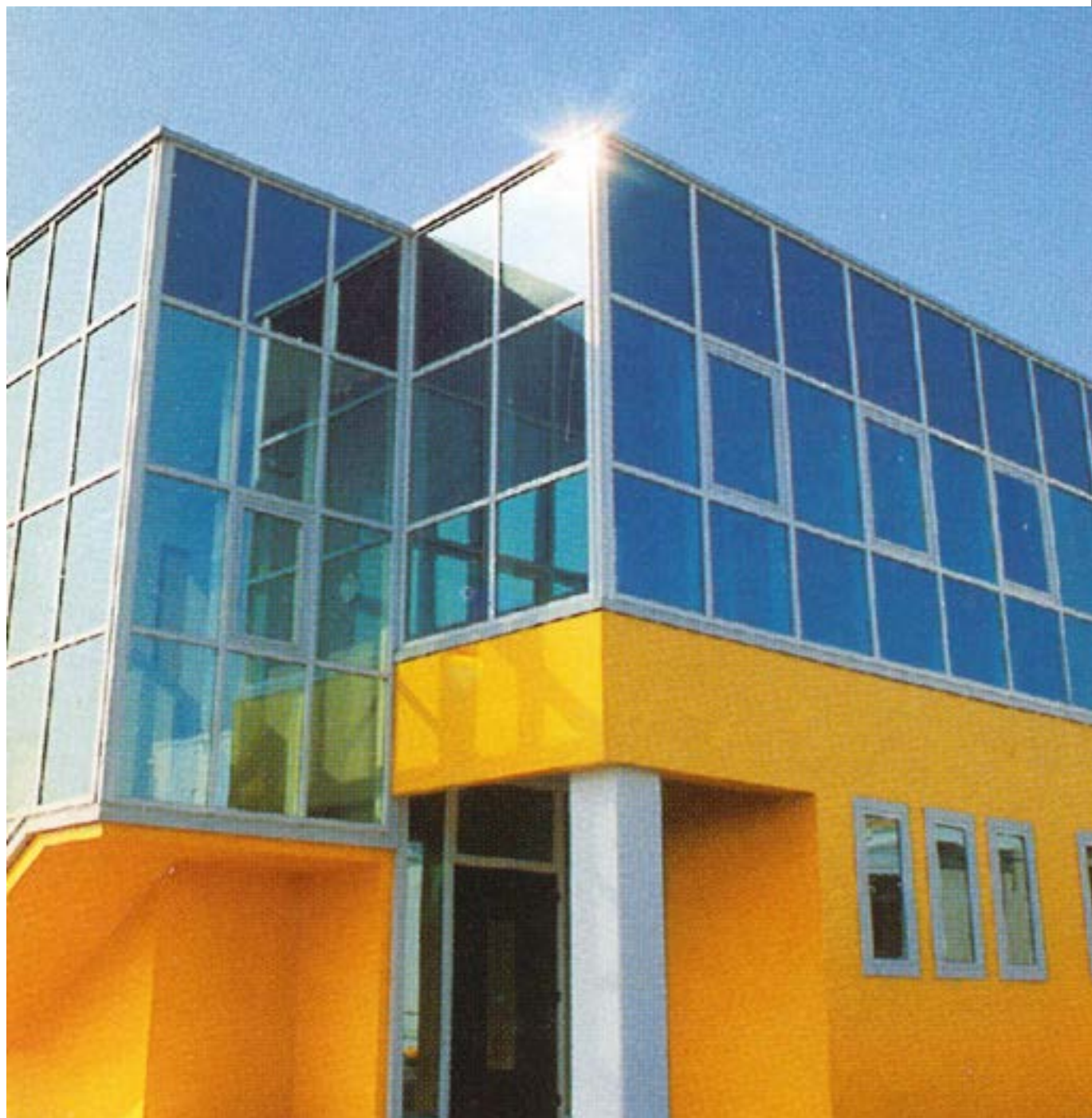
1991 - Nuova sede aziendale Soteco a Quarto d'Altino (Ve).
